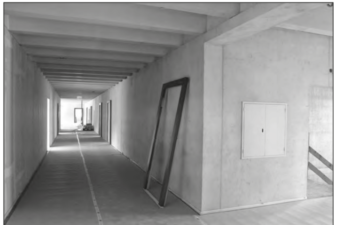
Auch der Innenausbau geht voran
