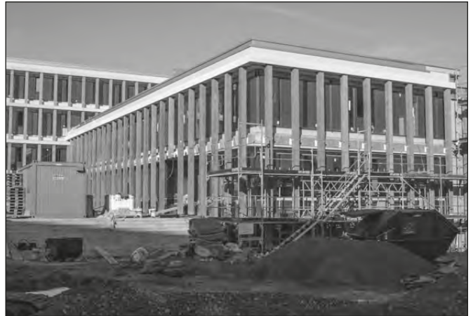
Turnhallentrakt mit neuer Treppe zum Haupteingang
