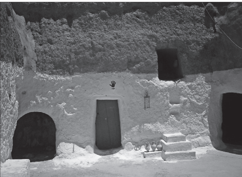
La cour d'une maison troglodyte verticale
