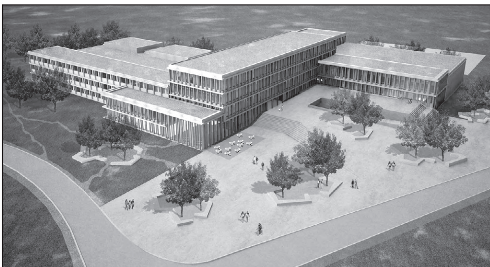
Projekt Neu- und Umbau der Kantonsschule Heerbrugg
